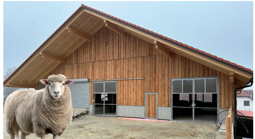
Besichtigung des neu errichteten Schafstalls der LFS Kirchberg am Walde
